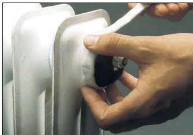
Sellado de una fuga en un radiador
